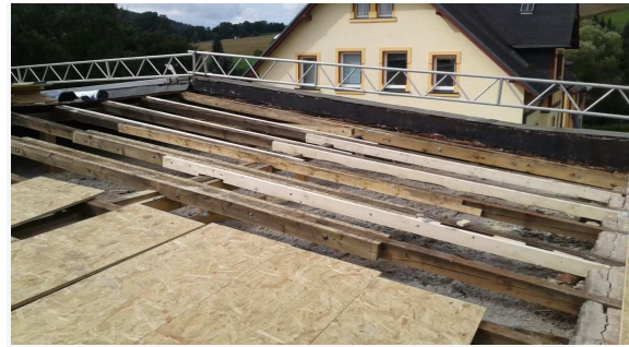
geöffnetes Dach des Gemeinschaftszentrums
