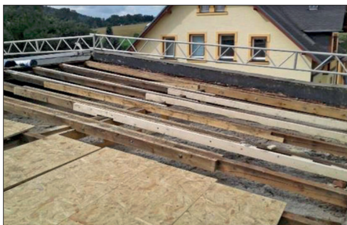
geöffnetes Dach des Gemeinschaftszentrums
