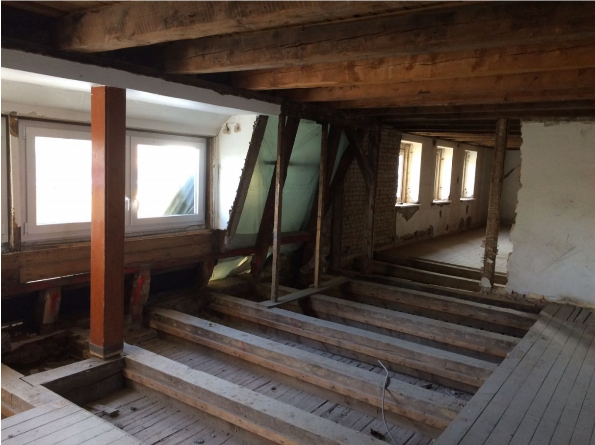
Dachgeschoss (Hausschwammbefall)
