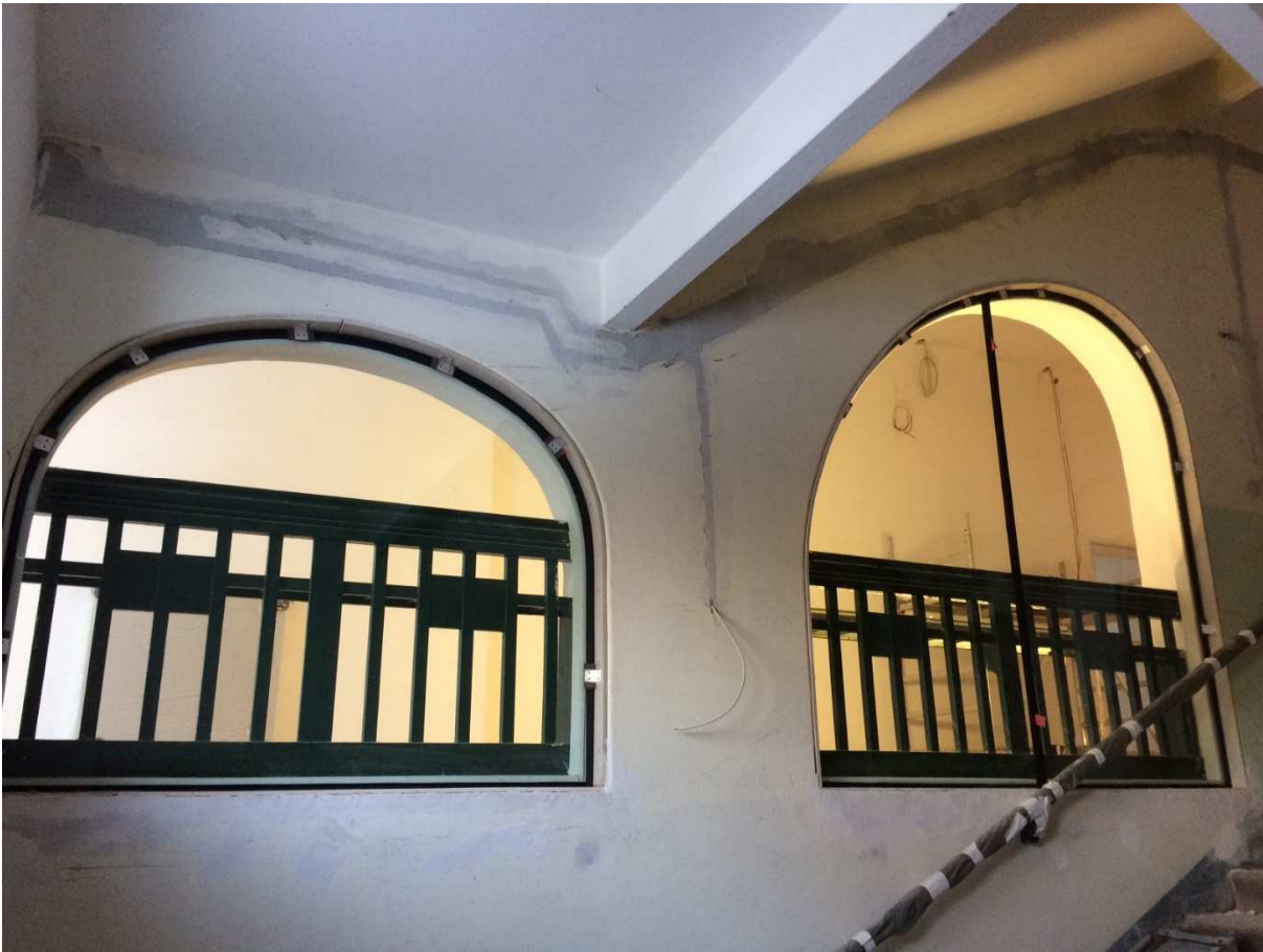
Treppenhaus mit verglasten Bögen
