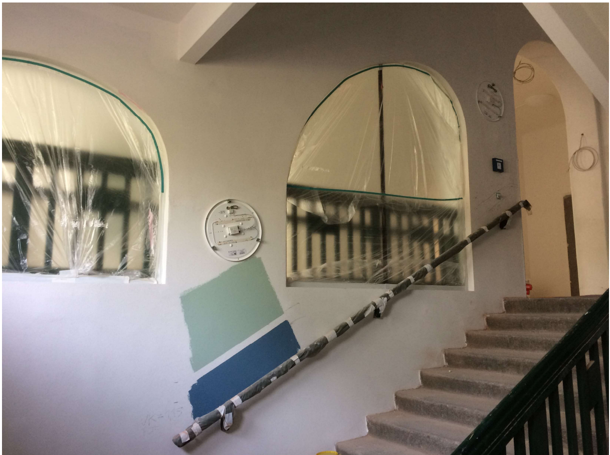
Treppenhaus mit Farbproben
