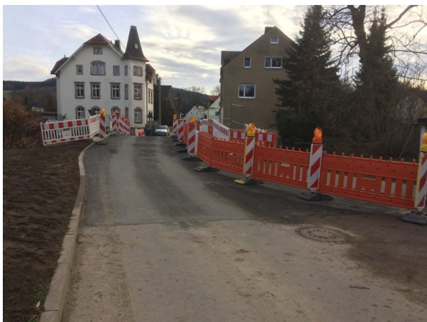
Brücke Alte Poststraße
