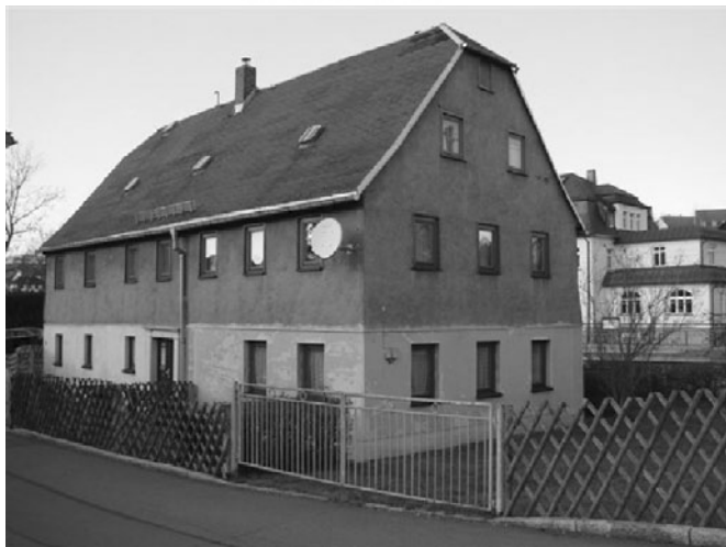
Abbruch ehem. Wohnhaus, Topfmarkt 4
