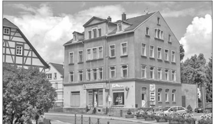
Neues Fochtmannhaus Am Markt 14 vor dem Abriss 2013
