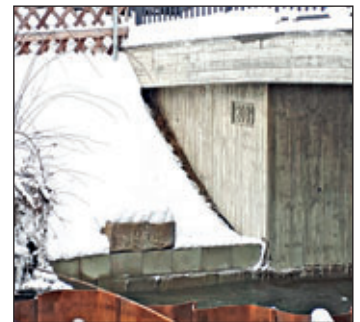
neue Brücke mit altem Stein, Zustand am 11.02.2021
