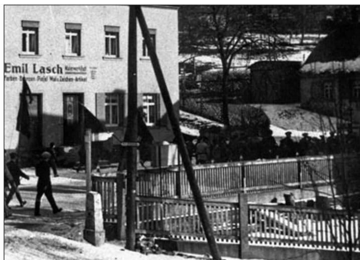
Standort Ecke Untere Hauptstraße/Alte Poststraße
