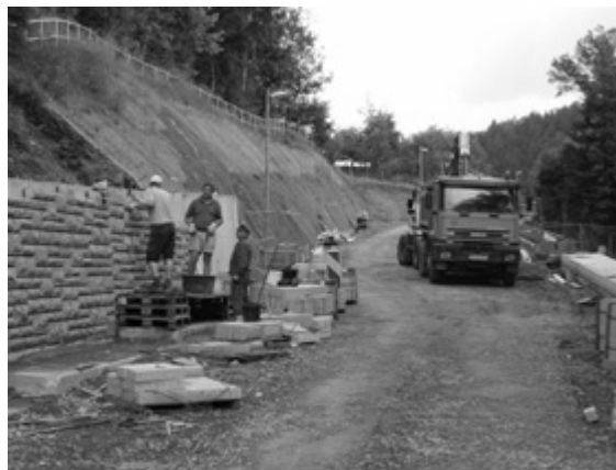
Verblendung der Mauer mit Natursteinen
