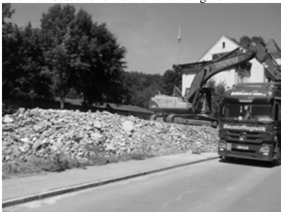
Baustelle Grundstück Bahnhofstraße 15
