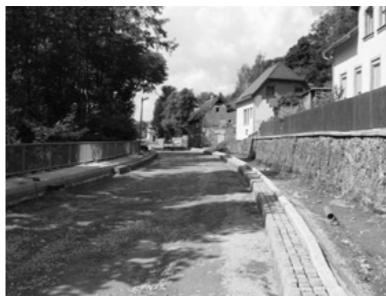
Blick auf die Eibenberger Straße in Höhe der Mühlwegbrücke
