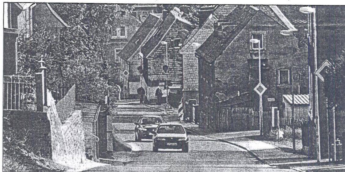
Seit gestern herrscht auf der Meinersdorfer Hauptstraße wieder freie Fahrt. Der 1,5 Kilometer lange Abschnitt der Kreisstraße 8803 konnte nach 26 Monaten Bauzeit vorfristig übergeben werden. –FOTO: ANDREAS TANN
