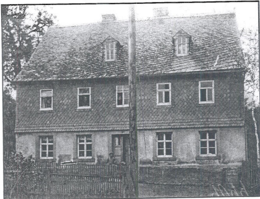
Alte Dorfstraße 2, erbaut um 1780
