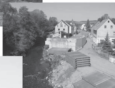
Die Behelfsbrücke ist abgebaut
