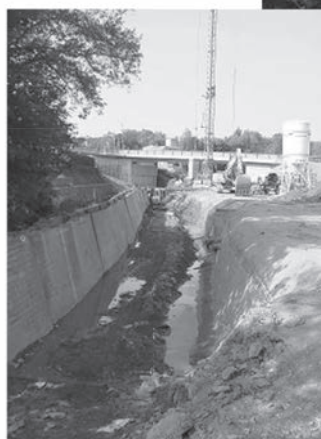
Bauarbeiten Ufermauer Untere Hauptstraße Richtung Kemtau
