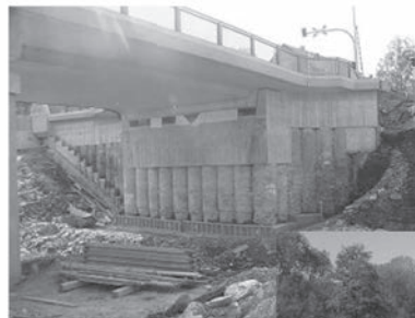
Brückenpfeiler der neuen Brücke
