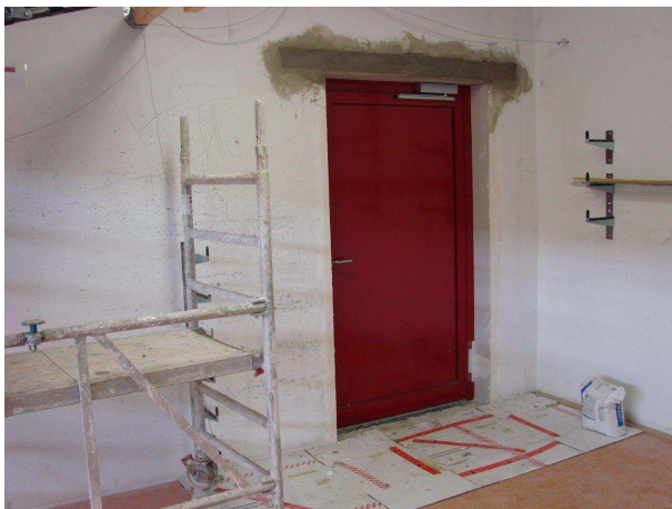
Im Geräteraum der Eurofoam arena wurde eine separate Eingangstür eingebaut.
