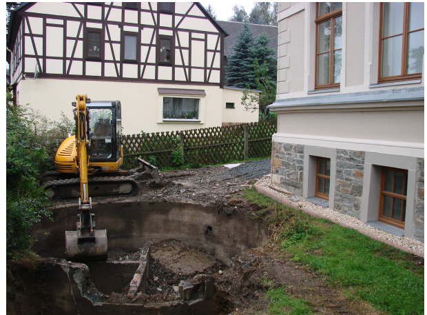
Die Kläranlage der Evangelischen Oberschule Burkhardtsdorf, Haus 1 (Kurt-Richter-Schule) wird derzeit abgebrochen, weil das Schulgebäude an das öffentliche Abwassernetz angeschlossen wird.
