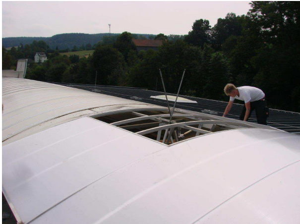
Die Eurofoam arena erhielt ein neues Lichtband des Oberlichtes. Es musste getauscht werden, da das alte auf Grund eines Hagelschlages beschädigt war.
