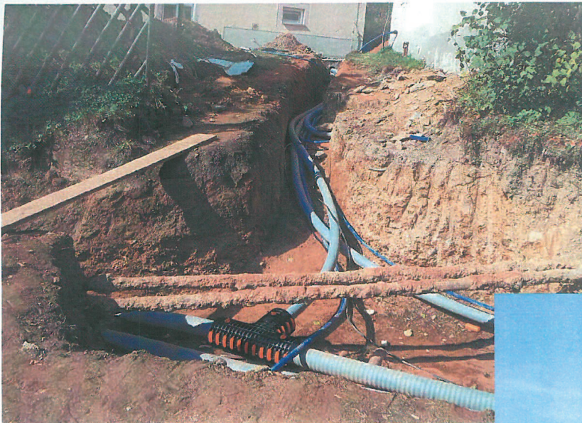
Verlegung des Nahwärmenetzes nach Burkhardtsdorf von 850 m Länge
