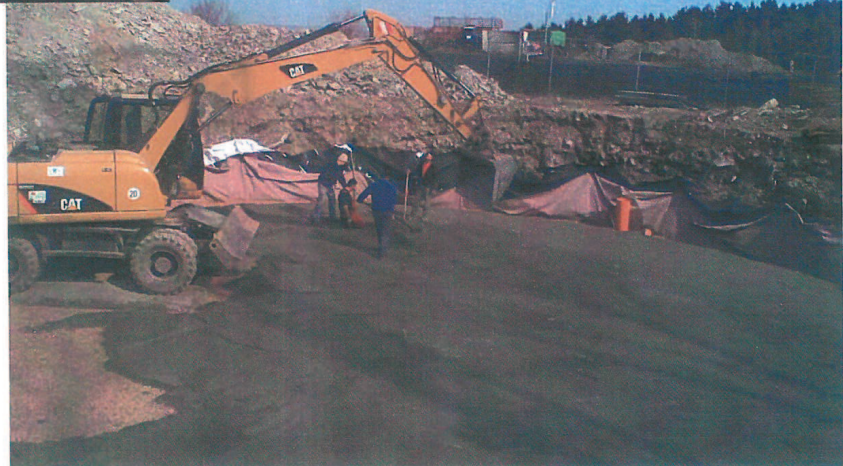
Baubeginn der Gaserzeugungsanlage im April 2011
