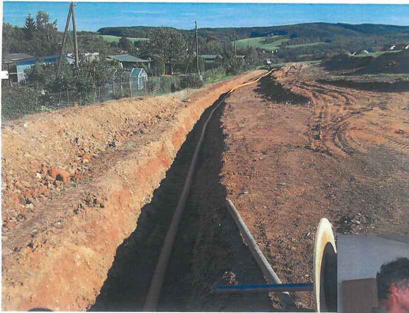
Verlegung des 1400 m langen Microgasnetzes nach Burkhardtsdorf im Sommer 2011
