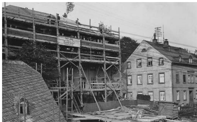
Aufstockung des Fabrikgebäudes 1927
