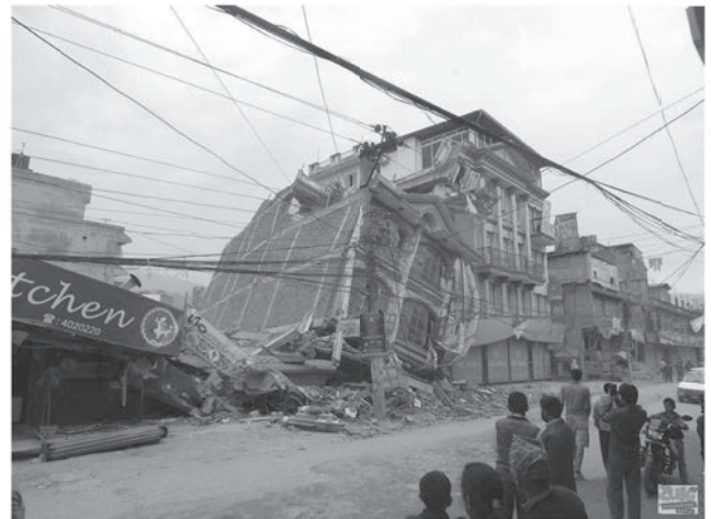
zerstörte Häuser in Kathmandu, Samakushi
