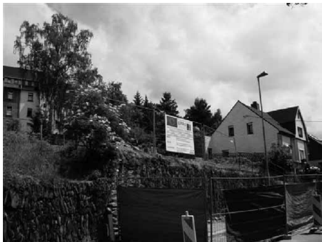
Ansicht des Grundstückes von B 180 aus am 08.6.2011
