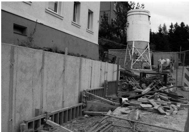
Errichtung Stützwand B 180, 13.07.2011
