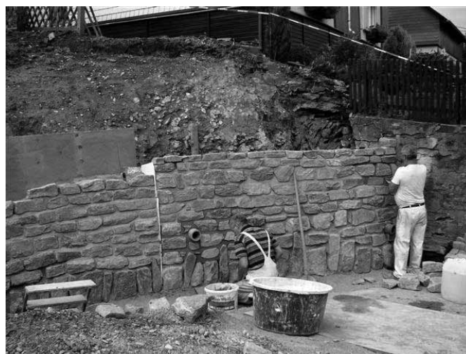
Errichtung der Stützwand, 13.07.2011
