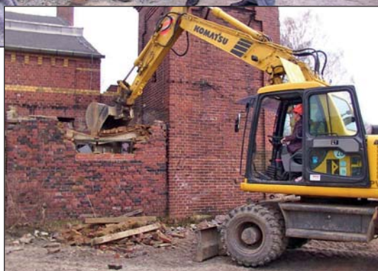
April 2002 - Abriss Industriebrache
